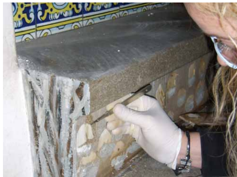
Proves d'eliminació d'afegits en una contrapetja de l'escala.
