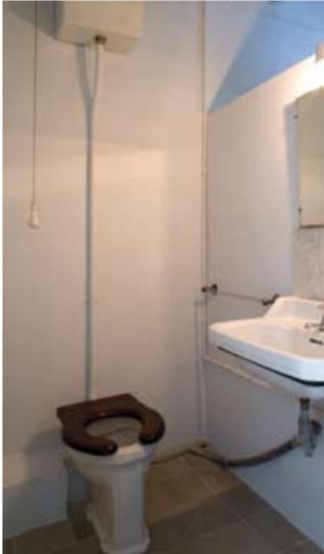
Los demás paramentos, tanto interiores como exteriores, verticales y horizontales, rebozados, enyesados y falsos techos se han pintado con dos capas de imprimación y dos de acabado con pintura del mismo tipo que la que se utilizó en origen. La parte de arrimadero de la ducha se ha recubierto con tres capas de pintura esmaltada, protegiendo así la pared de la humedad, tal como se había hecho en el edificio original.
